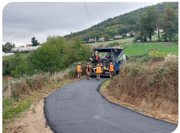
Mise en route du tapis d'enrobé route des Vergers
